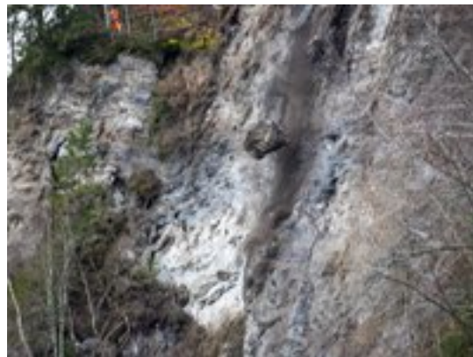
Abstürzender Block während der Felsräumung
